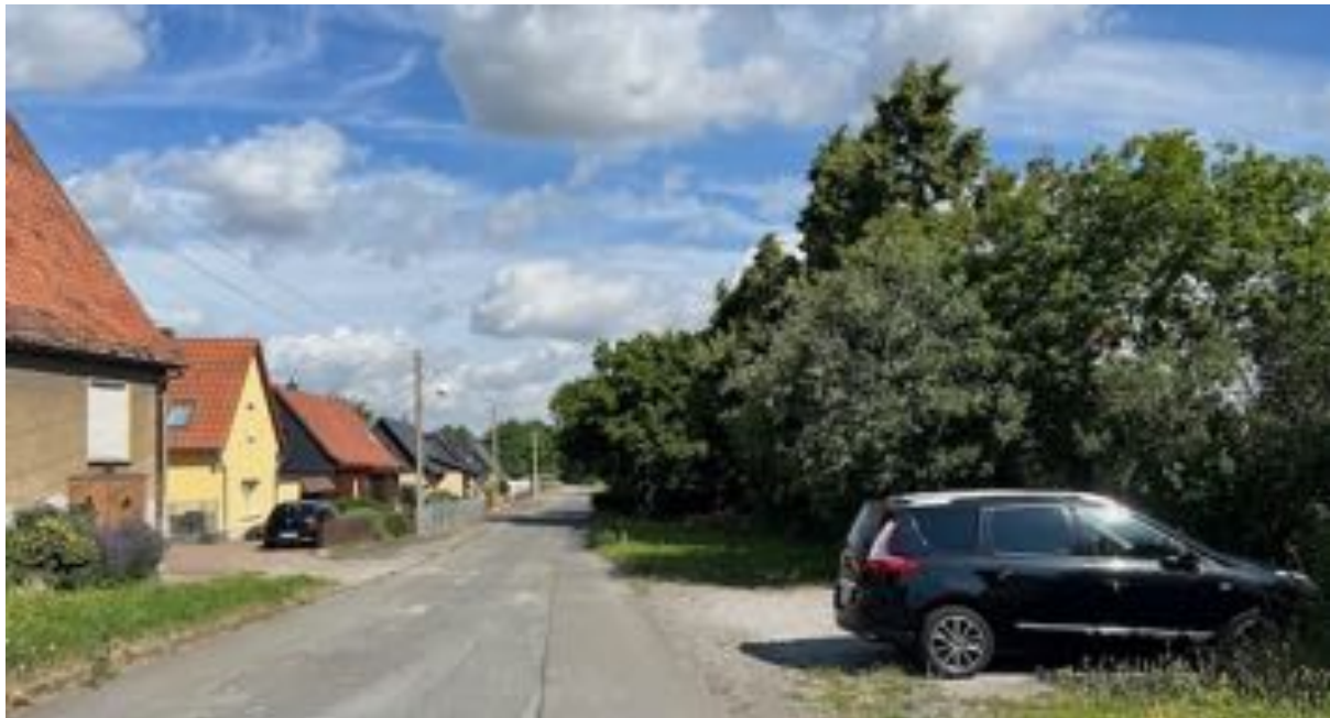
Die Bäckerstraße ist ebenfalls in einem schlechten Ausbaurzustand und ohne Geh- und Radwege / Aufnahme 2023 K.Schube
