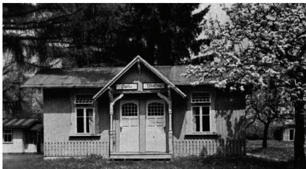
Abbildung 207: Licht-Luft-Hütten, historische Aufnahme und Neubau
