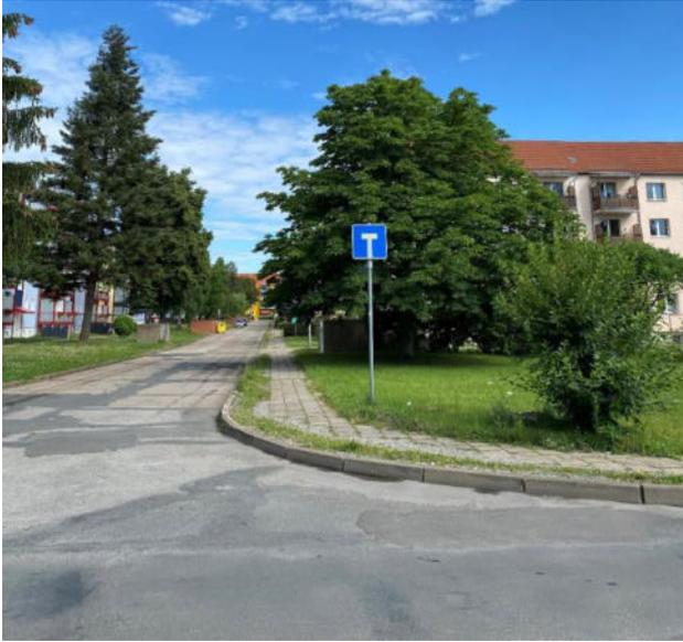
*Abbildung 44: Straen und Fuweg mit Sanierungsbedarf und fehlender abgesenkter Bordstein*
