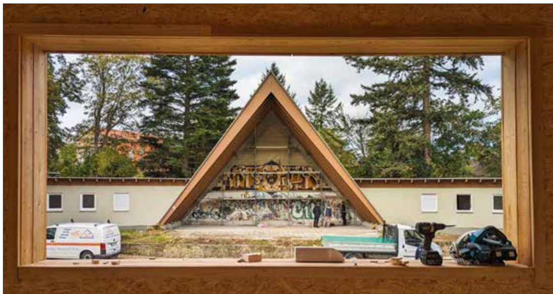
Die Sanierung der Parkbühne ist in vollem Gange. Auch das Regiehäuschen wurde erneuert und ermöglicht Veranstaltungstechnikern künftig einen guten Blick zur Bühne. Foto: Jana Böhme
