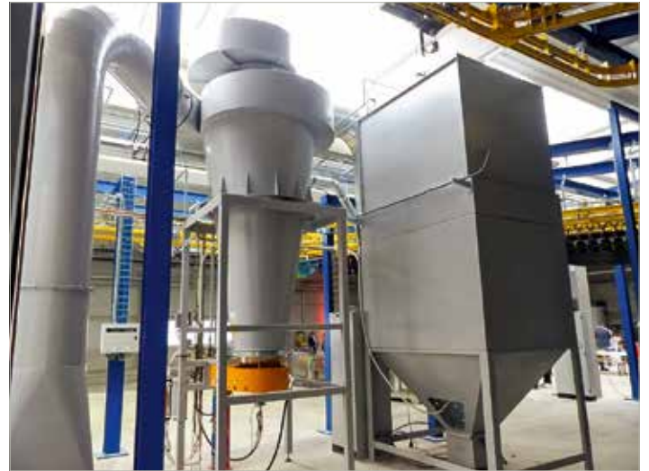
Rund 6,5 Millionen Euro wurden am neuen Standort investiert.
