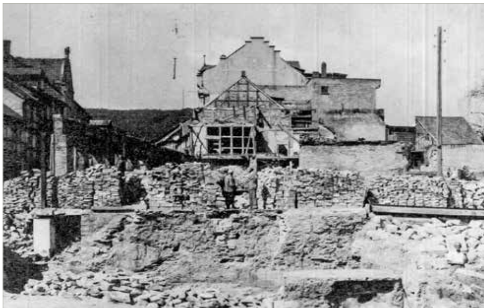
Das Hotel „Weißer Adler“ in der Langen Straße wurde bei den mehrtägigen Angriffen vollständig zerstört. Foto: Archiv der Stadt Blankenburg (Harz)
