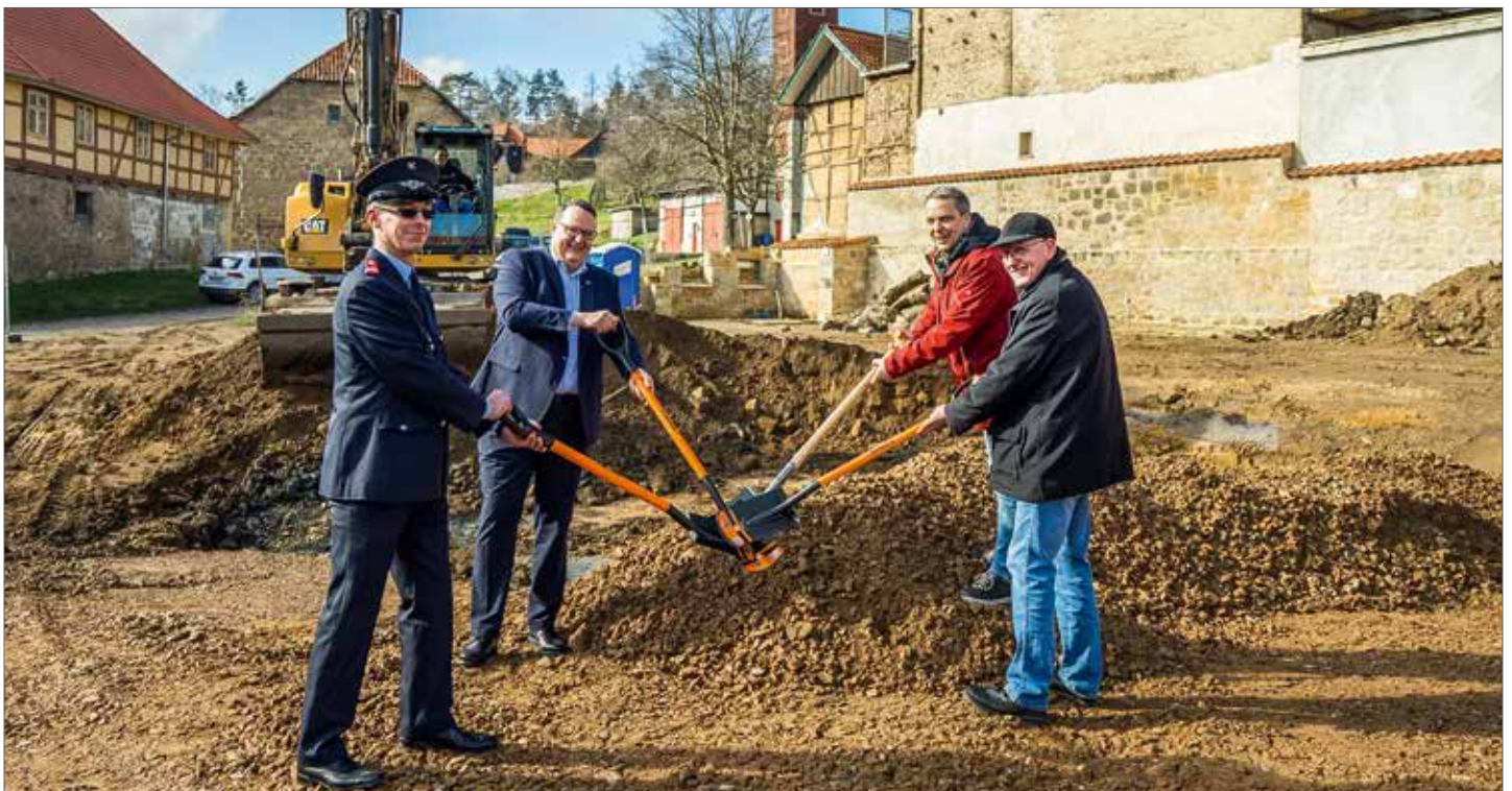
Mit einer Spatenlänge Abstand: Ortswehrleiter Stefan Spillker, Bürgermeister Heiko Breithaupt, Bauleiter Thomas Koch und Ortsbürgermeister Rüdiger Klamroth beim symbolischen Spatenstich Ende März.
