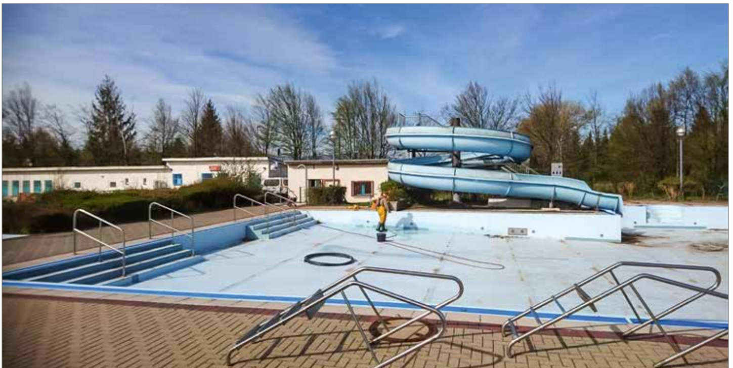
Heiko Hansen bei den Vorbereitungsmaßnahmen im Derenburger Freibad.
