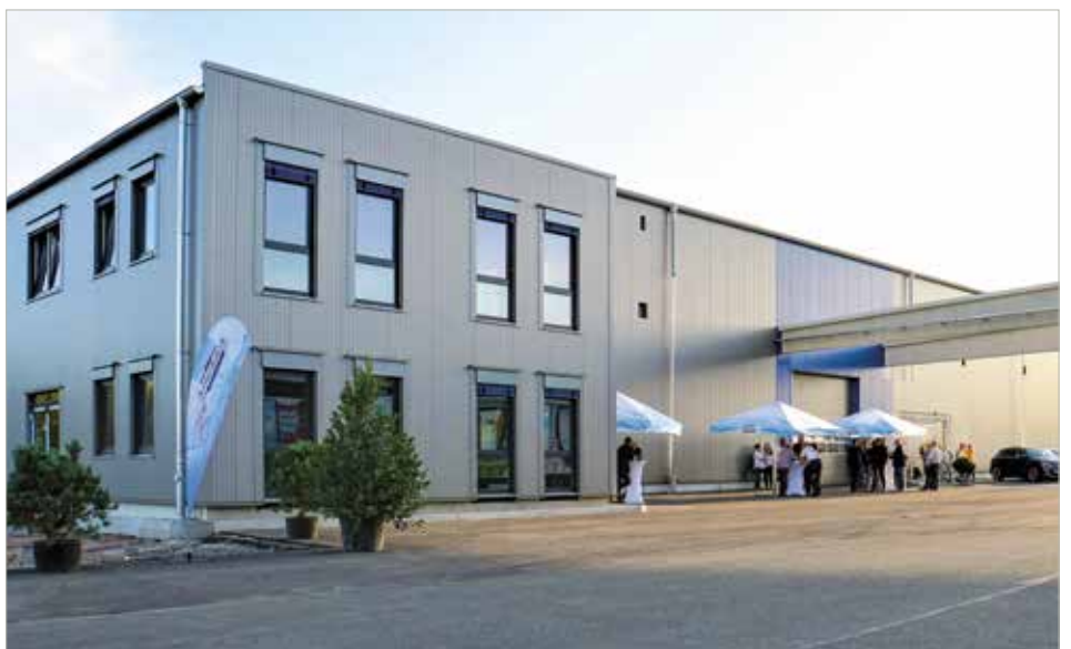
Das Betriebsgelände der Harzer Mineralquelle Blankenburg am Hasenwinkel mit dem neuen Logistik-Zentrum.
