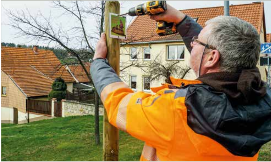
Karl Heinz Grabe befestigt in Timmenrode die Beschilderung für den Teufelsmauerstieg.
