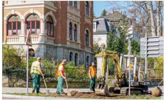
Mitarbeiter der Firma Garten- und Landschaftsbau Axel Krimmling beim Setzen der Bäume. Foto: Bennet Dörge
