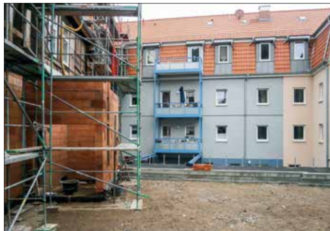
Während die Arbeiten am Haus Lange Straße 42 (hinten) praktisch abgeschlossen sind, ist die Rückfront der Häuser an der Tränkestraße (links) noch eingerüstet.
