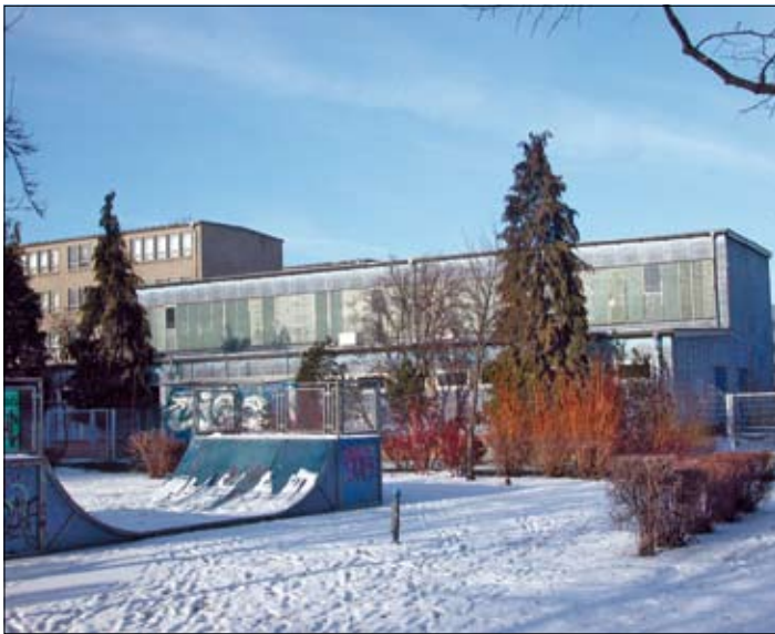
Die Tage der Grundschule am Regenstein sind gezählt. Hier entsteht in Kürze ein komplett neues Schulgebäude.
