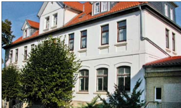
In diesem Gebäudeteil der Timmenröder Grundschule sollen zwei Klassenräume und der Flur saniert werden.
