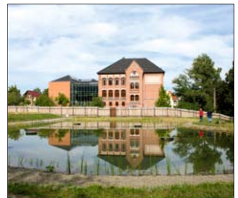
In zwei Naturbecken wird das Wasser für das Freibad am Thie aufbereitet.
