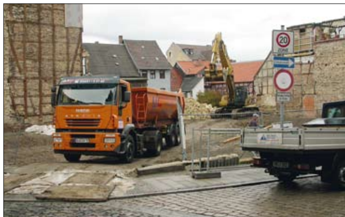
Die Bauarbeiten an der Langen Straße haben inzwischen begonnen.
