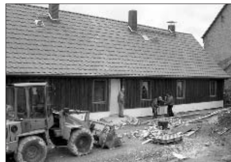
Noch Baustelle, das „Alte Amtshaus“.
