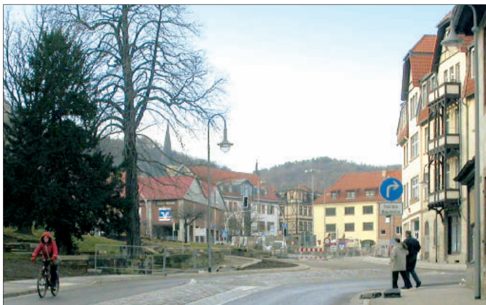
Die Fußgänger können bereits jetzt die Westerhäuser Straße sicherer überqueren.
