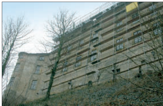
Am Großen Schloss wird weiter gearbeitet. Diesmal geht es um Sicherungsarbeiten im Dachbereich über dem Kapellenflügel sowie die Untersuchung und Beseitigung von Hausschwamm. Dafür wurde an der Fassade an der Stadtseite im vorigen Monat dieses Gerüst errichtet.
