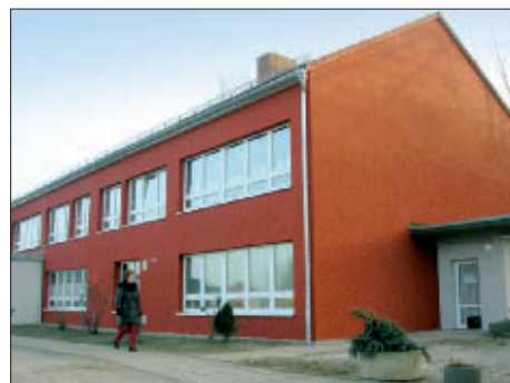
Mit leuchtenden Farbanstrich zeigt sich seit kurzem das Timmenröder Gemeindehaus.
