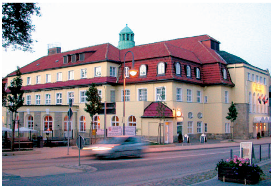
Das „Kur- und Wellnesshotel Fürstenhof“ erstrahlt auch von außen in völlig neuem Glanz. Im Restaurant „Vis-a-Vis“ soll es wieder regelmäßige Veranstaltungen für die Blankenburger geben.
