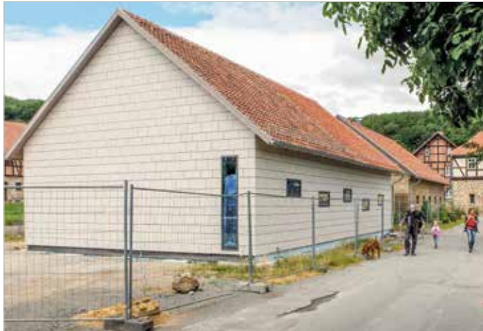
Das neue Gebäude fügt sich gut in die Umgebung der Klosteranlage ein.
